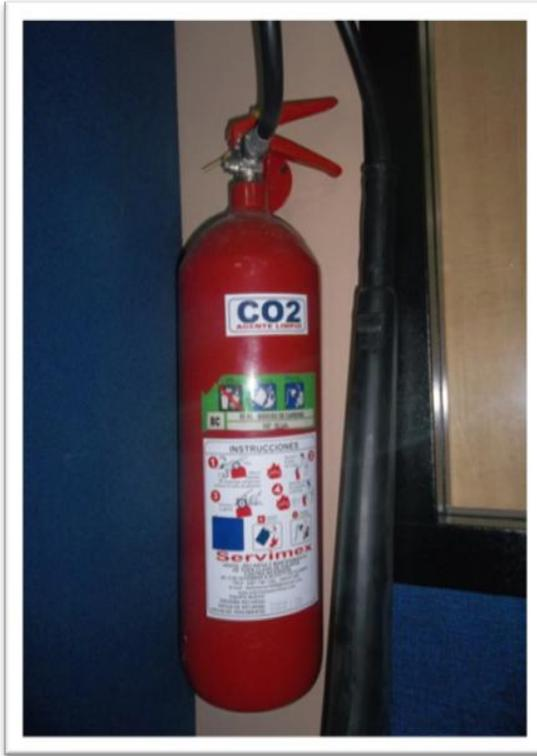
**Figura 14** Extintor CO2 tipo B.C
