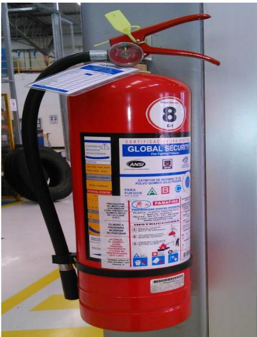
**Figura 13** Extintor tipo A.B.C
