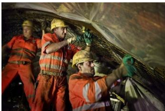
Figura 11. Calor y Humedad
